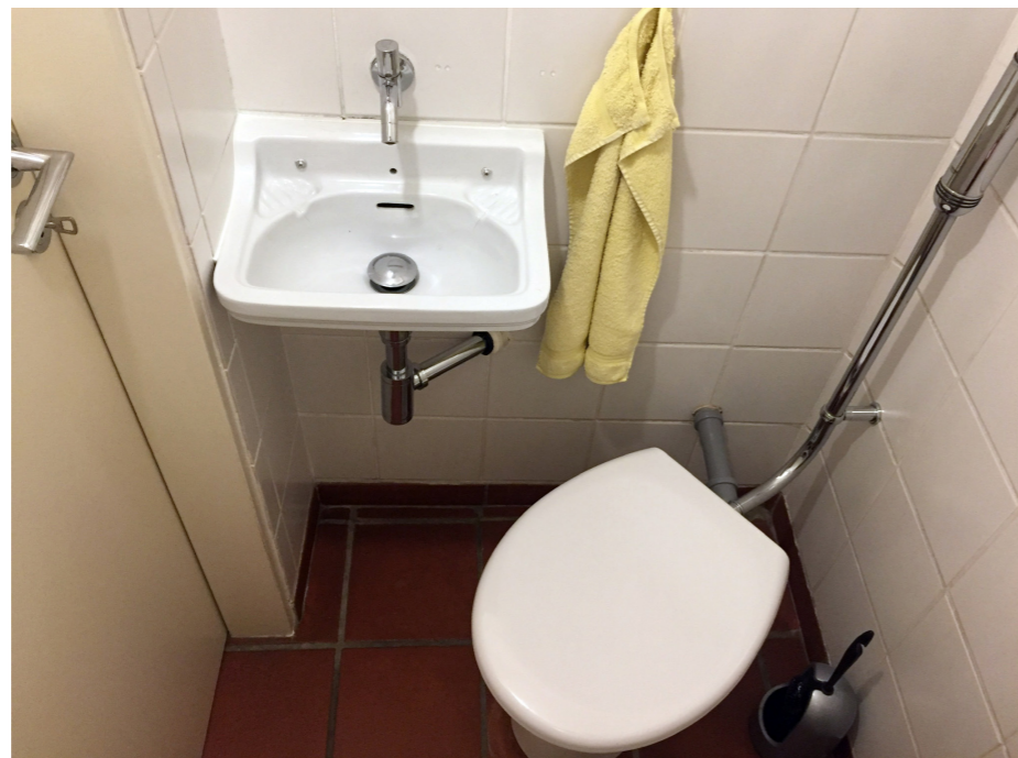
nach der Sanierung vor der Sanierung
